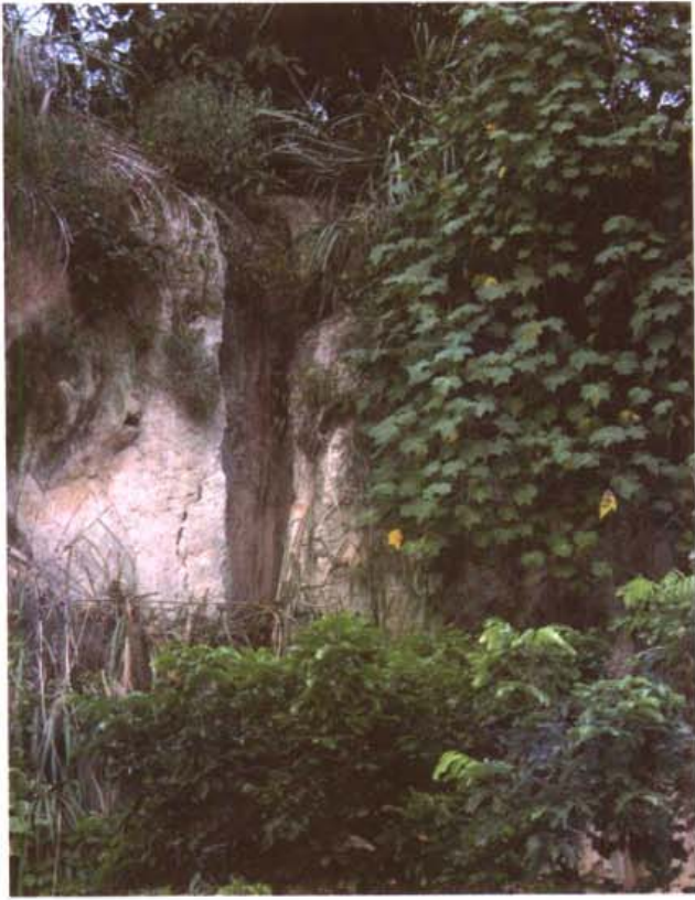
雨水冲刷，造成山体冲沟
