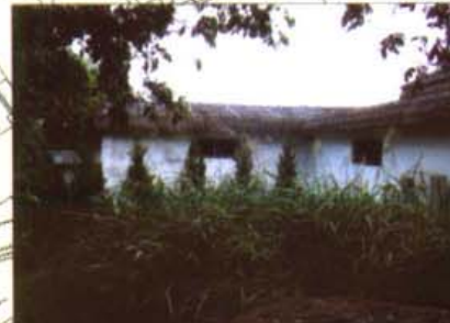
遗址展示厅外墙
