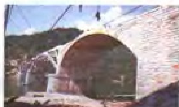
兴建中的华安山区黄枣大石拱桥
