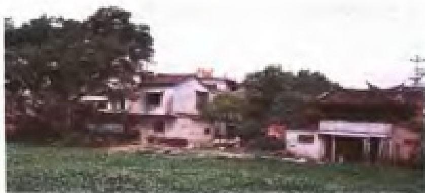
漳州浦头港定湖楼古码头遗址
