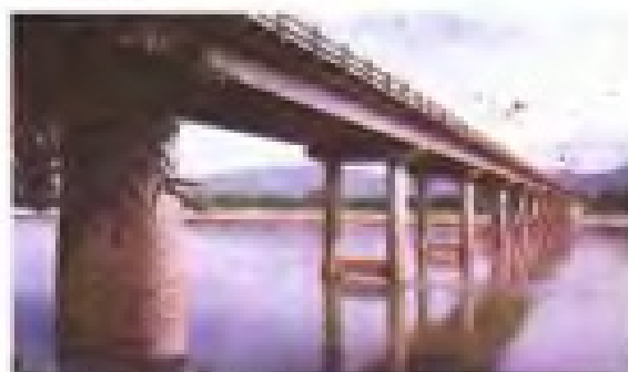
民办公助建成的南靖靖城大桥
