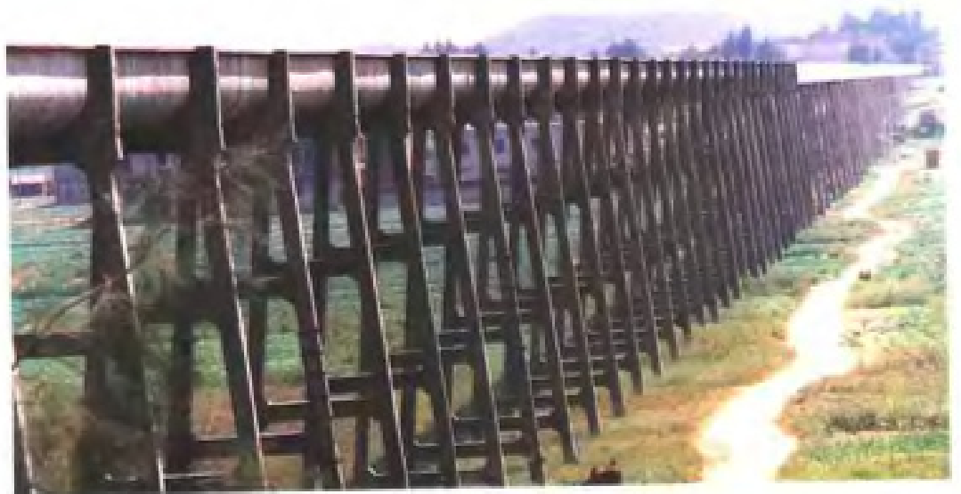
社厝引水堤槽
