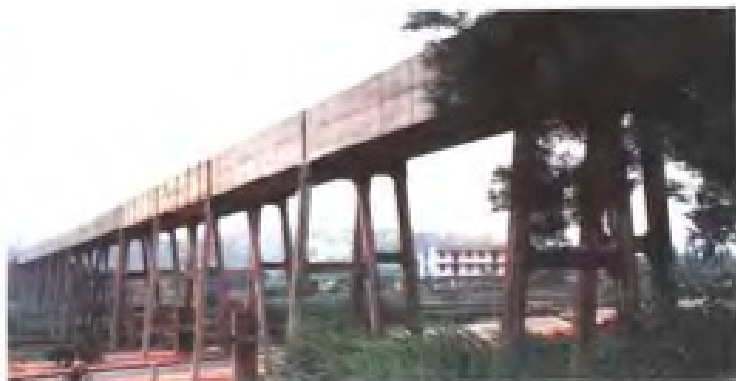
引水工程：坂尾渡槽
