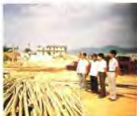
泉州市僑辦領導檢查僑建工程
