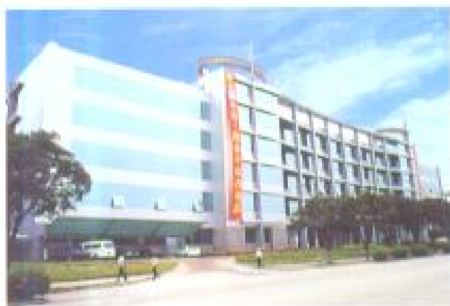
厦华电子工业有限公司
