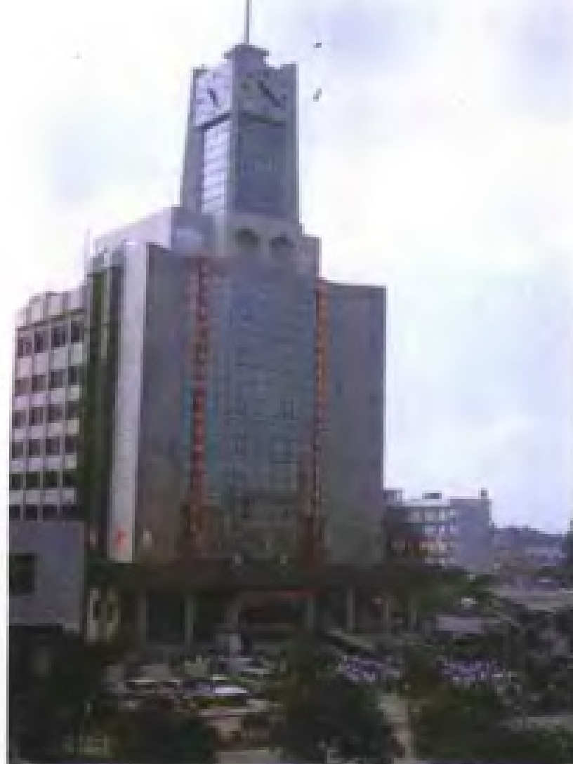
泉州海关大楼
