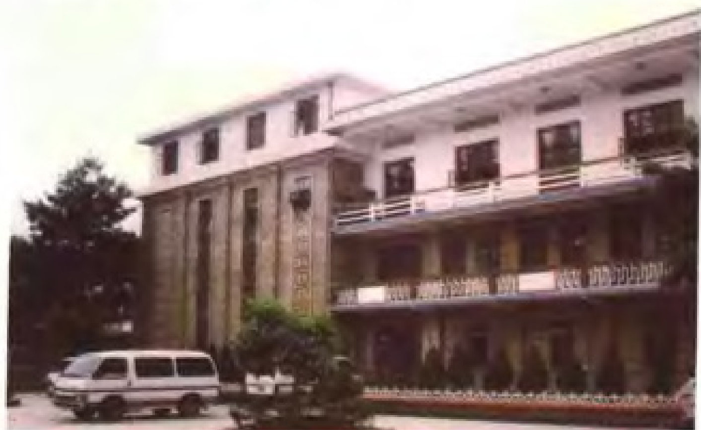
江口镇人民政府办公大楼
