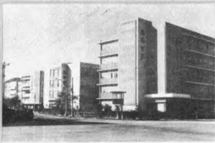
湖里工业区 一隅——厦 门华侨电子 有限公司部 份厂房
