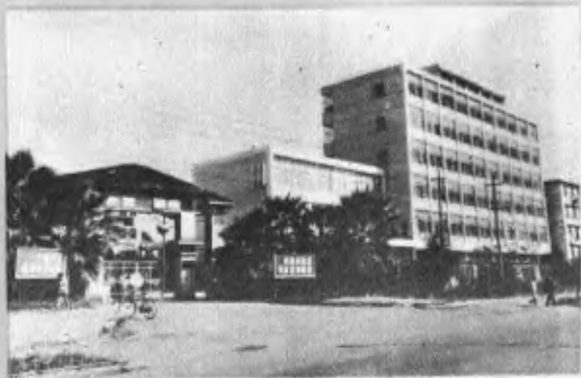
厦门新华玻璃厂（杏林）
