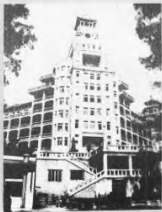
集美学村最高层建筑——南薰楼
