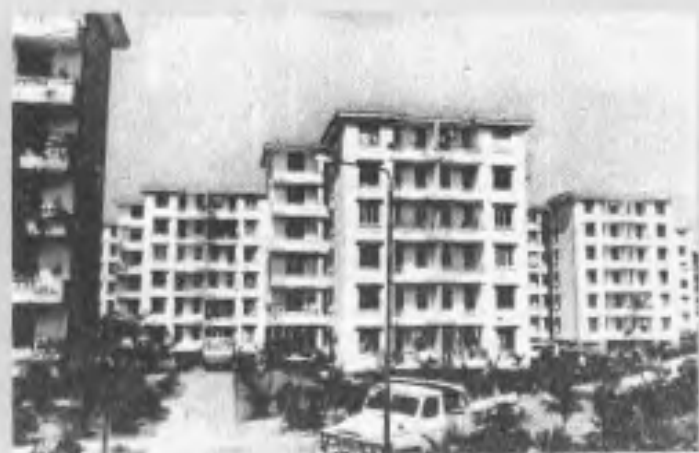
莲花新村住宅群一角
