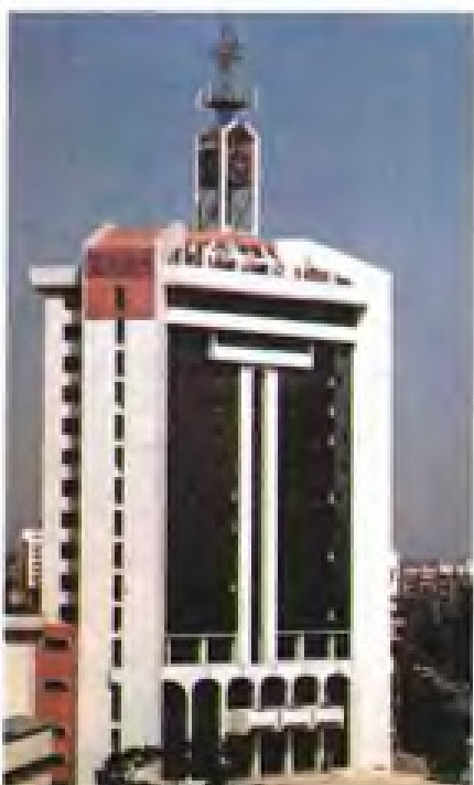
△泉州邮电大楼
