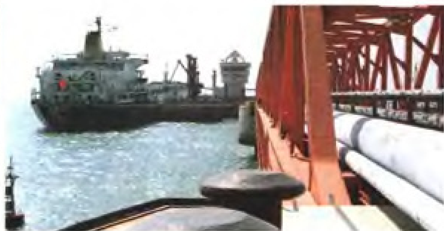
△惠安肖厝 10 万吨级油码头一角
