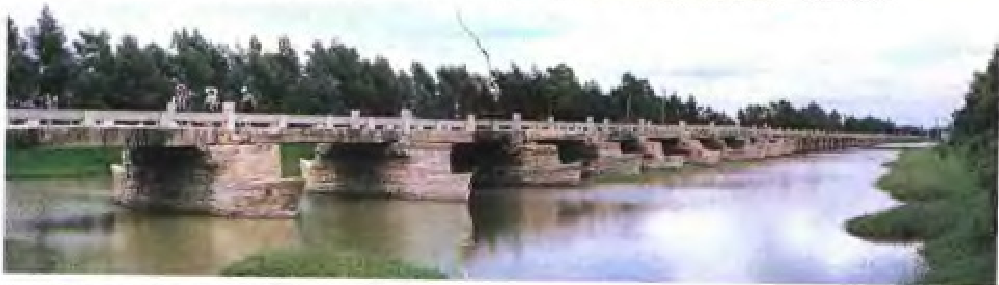
△宋代建造的全国最长的跨海石梁桥——晋江安平桥
