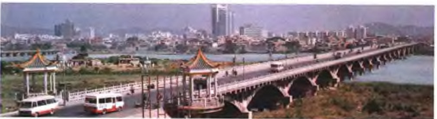
△独具侨乡建筑风格的福建省大型公路桥梁——泉州大桥
