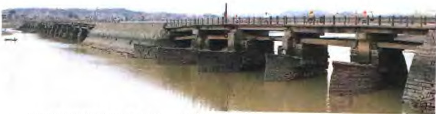
△宋代建造的全国第一座跨海大桥——万安桥（今泉州洛阳桥），首创“筏形基础”等施工技术
