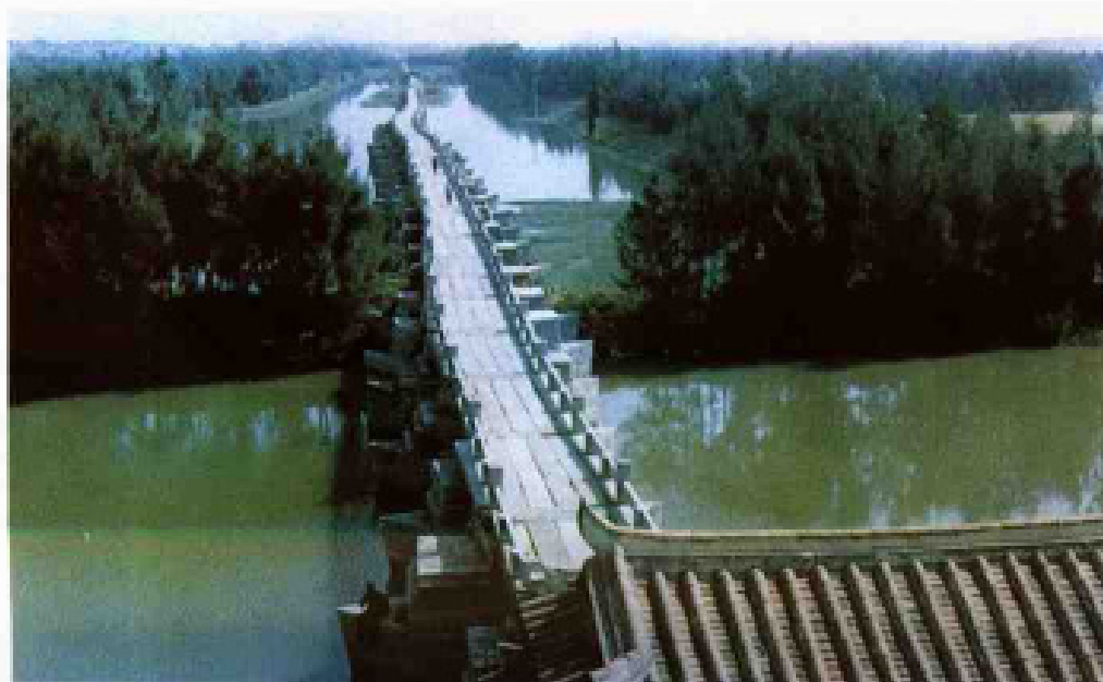
1 泉州东湖公园景色 2 建设中的东海滨城 3 晋江市安平桥
