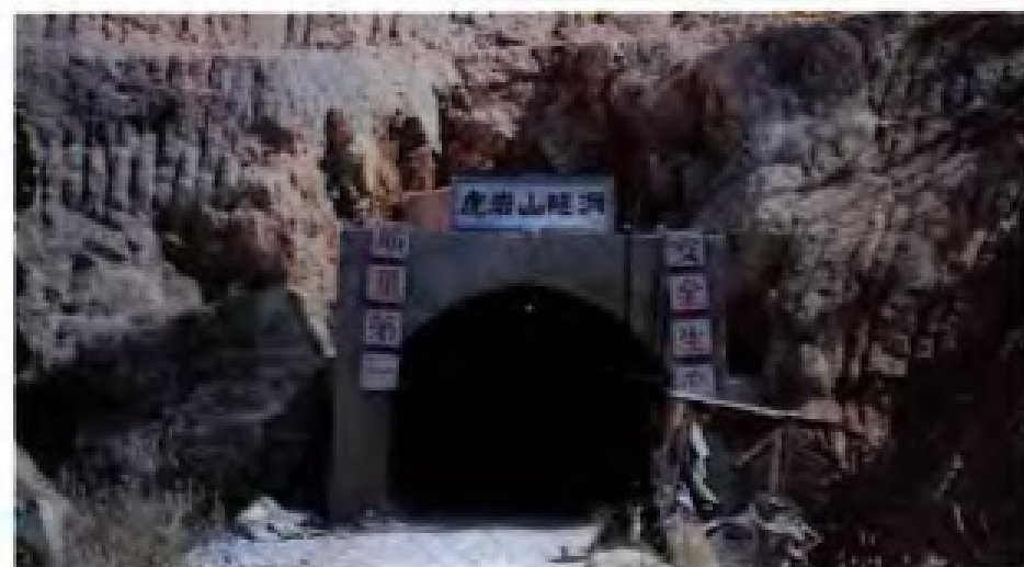
◀ 湄洲湾南岸供水工程 —虎岩山隧洞
