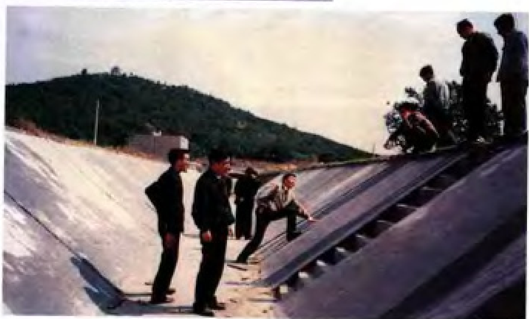
石壁南干渠 防渗渠段 ▶
