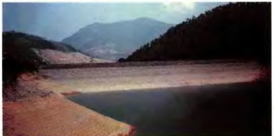
文溪水库大坝 ▶
