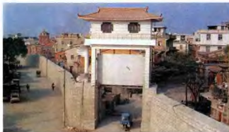
◀ 泉州防洪堤加固扩建工程聚宝街旱闸
