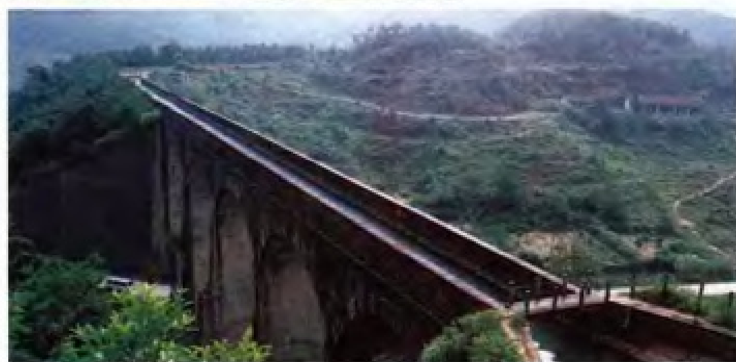
乌潭灌区南塘渡槽 ▶
