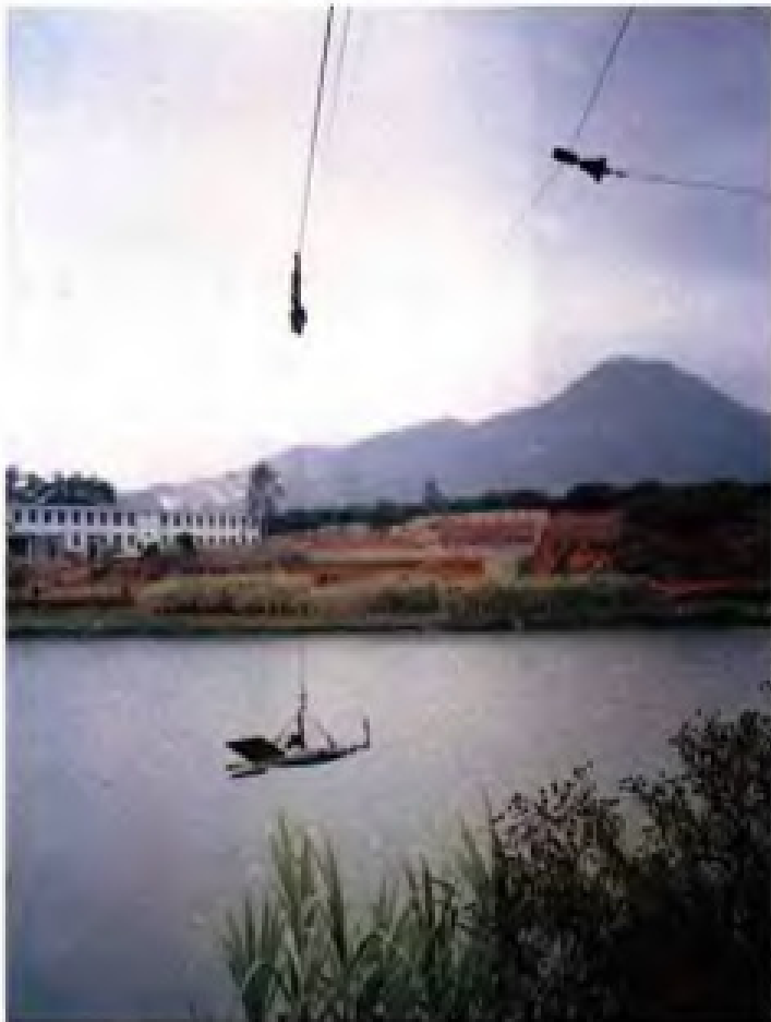
◀ 南安洪濑水文站缆道设施
