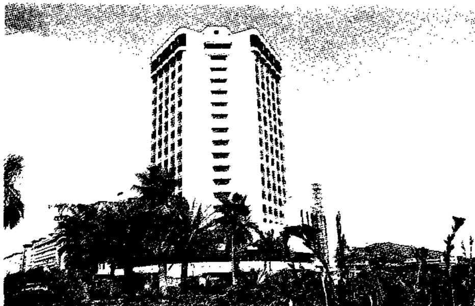
中国人民银行厦门分行办公大楼。
