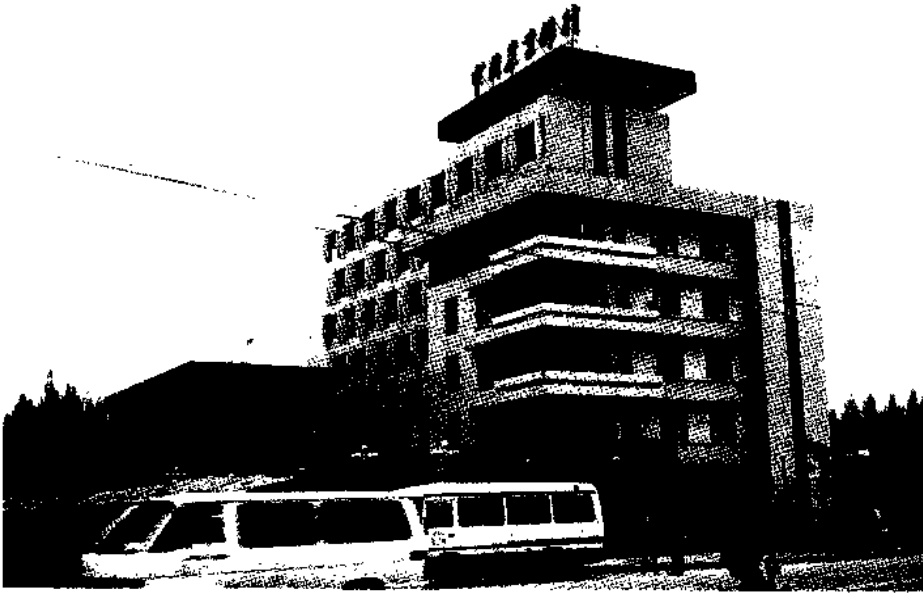
中国农业银行厦门市分行办公大楼。
