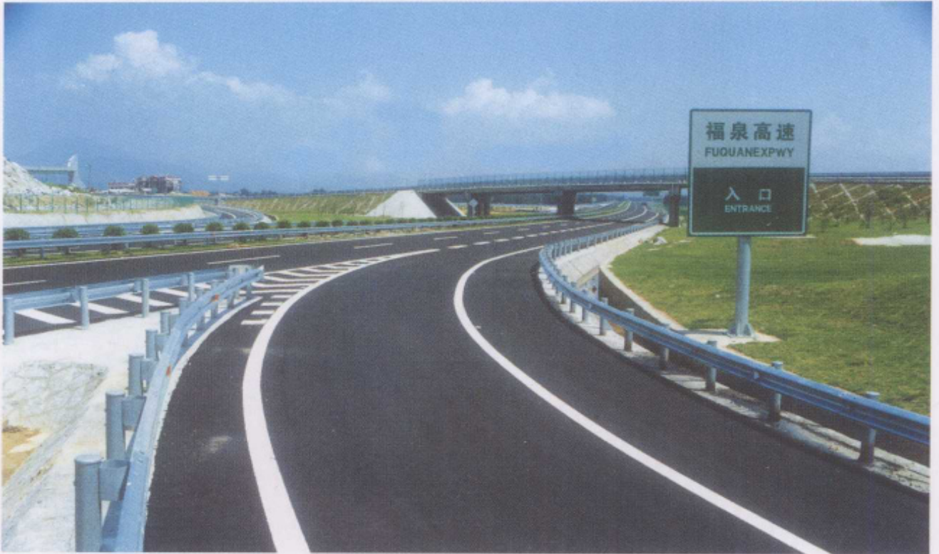
福泉高速公路涵江入口处
