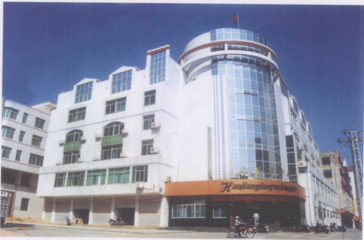
区教育中心大楼
