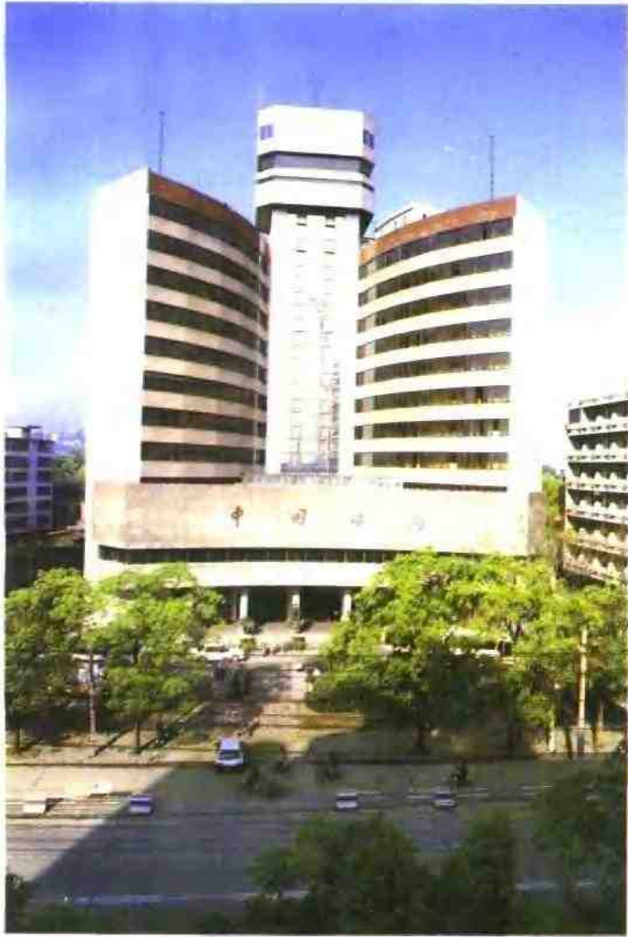
福州海关办公大楼
