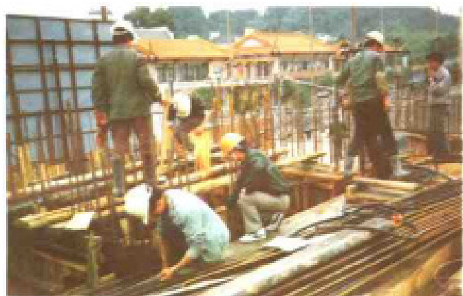
福州建筑工程职校学生在工地实践
