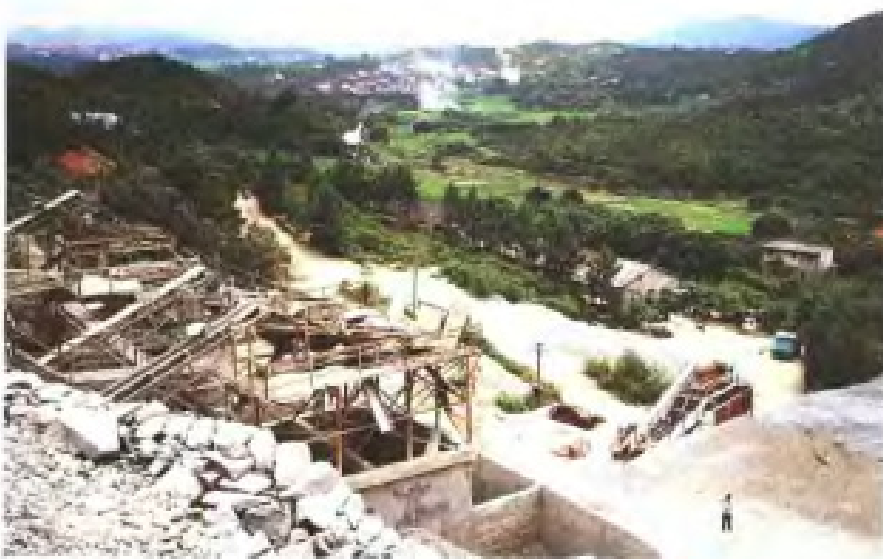
沙溪石场碎石生产线
