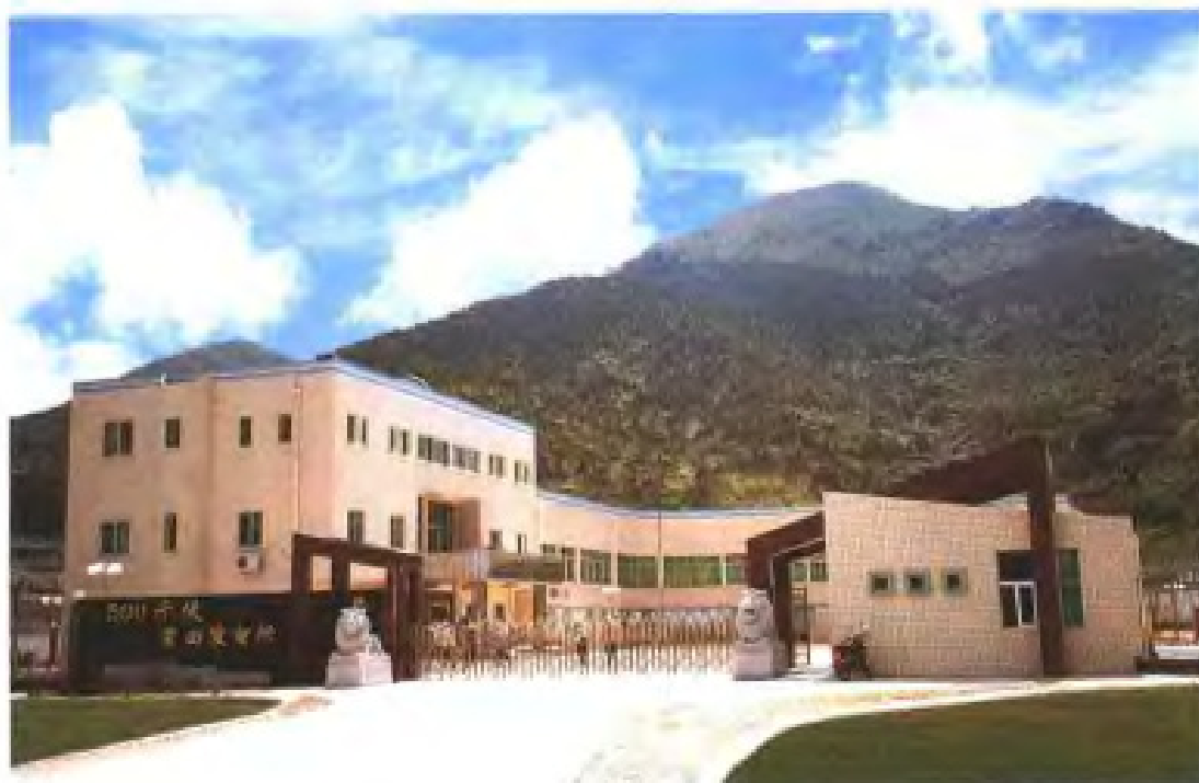
500千伏前田变电所
