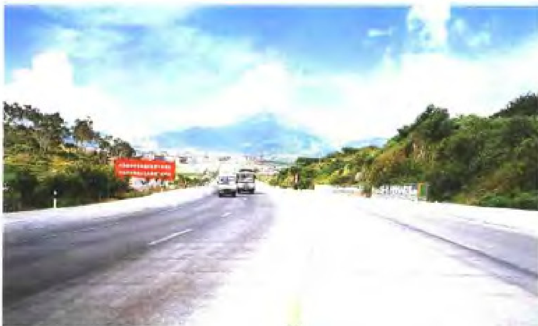
福厦公路 / 324 国道 / 郊尾路段
