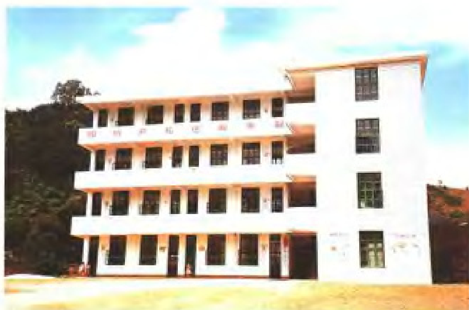
伍桥希望工程小学教学楼
