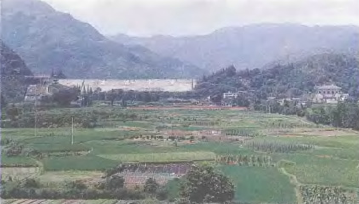
◀ 宁德金涵水库
