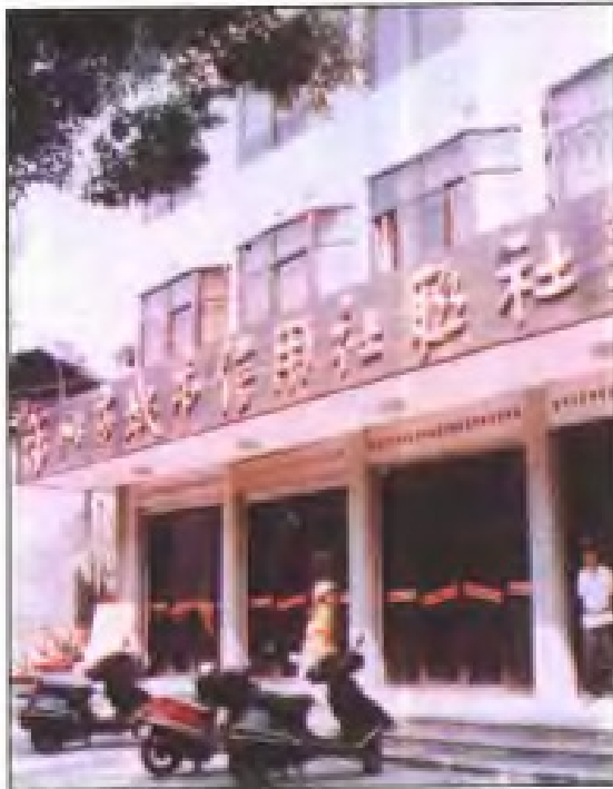
福州市城市信用社联社办公大楼
