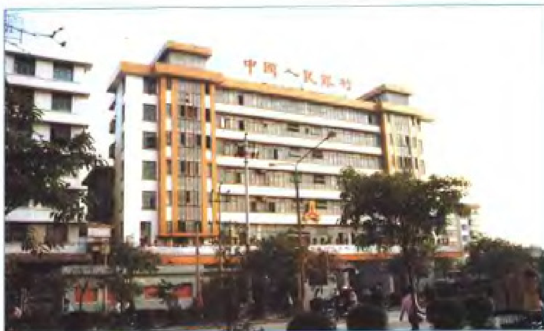
中国人民银行福州分行,外管局福州分局办公楼
