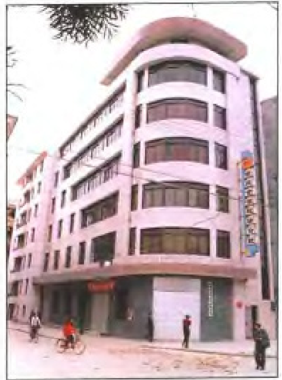
闽侯县农村信用合作社办公大楼
