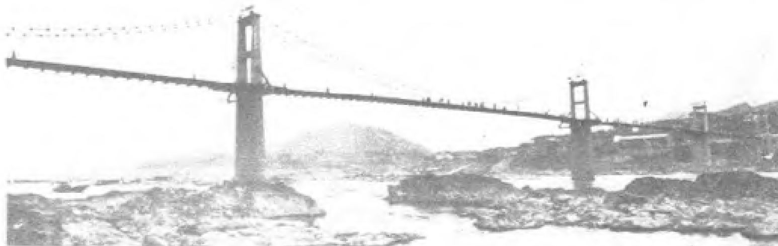
岡 江 尤 溪 口 悬 索 桥
