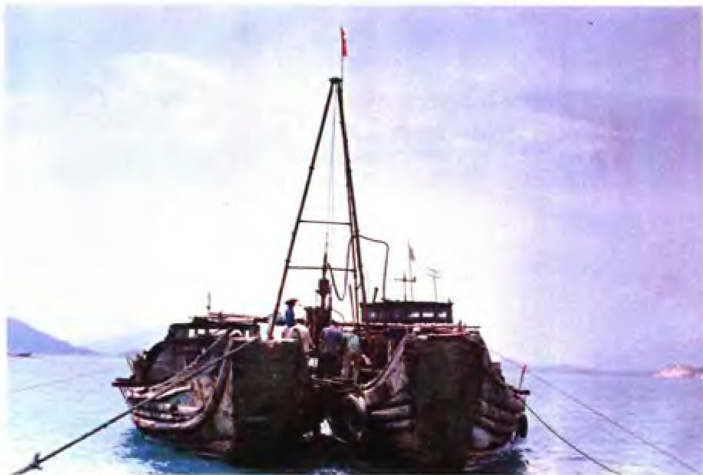
△福建省第四地质大队承担三都澳码头选址海上钻探工程。图为施工现场
