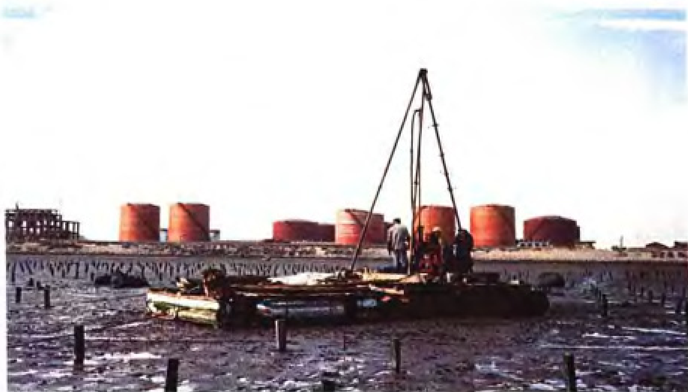
△省地质工程勘察院在福建炼油厂30万吨乙烯选址场地进行工程勘察
