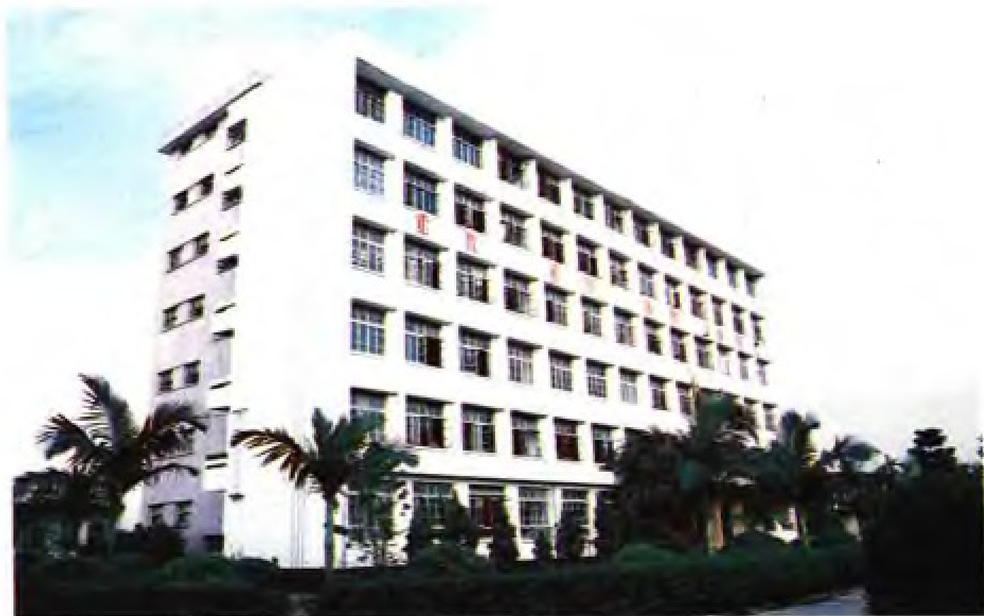
△福建地质学校教学大楼
