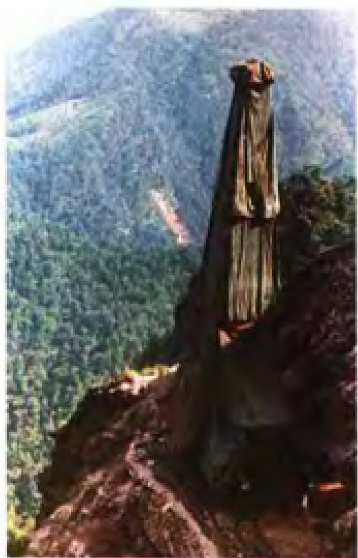
△钻机在紫金山矿区悬崖上施工
