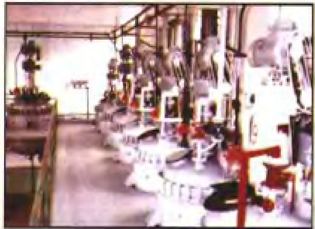
烟酰胺生产线(厦门第二制药厂) ▶
