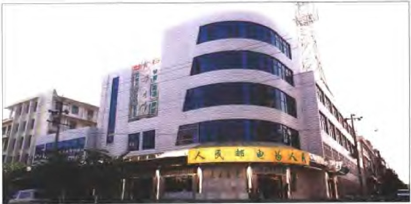
涵江“神经中枢”——邮电大楼
