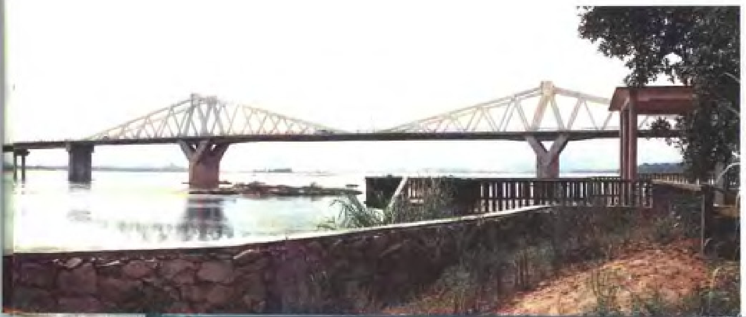
福州洪塘大桥
