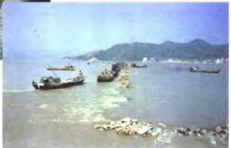
闽江口航道整治抛坝施工现场
