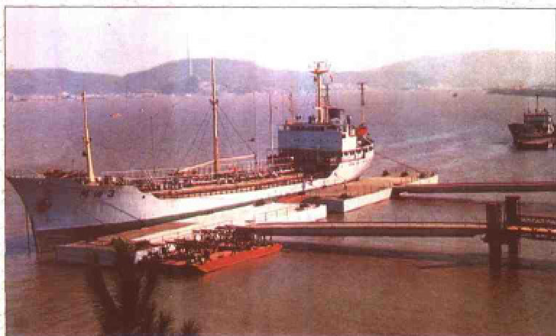
● 千吨级沿海快速搭建浮码头
