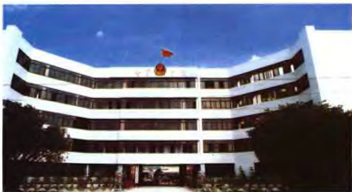
福建监狱警官学校综合楼
