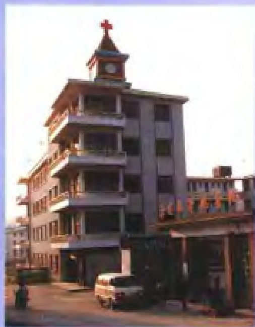
永定县下洋镇医院大楼
