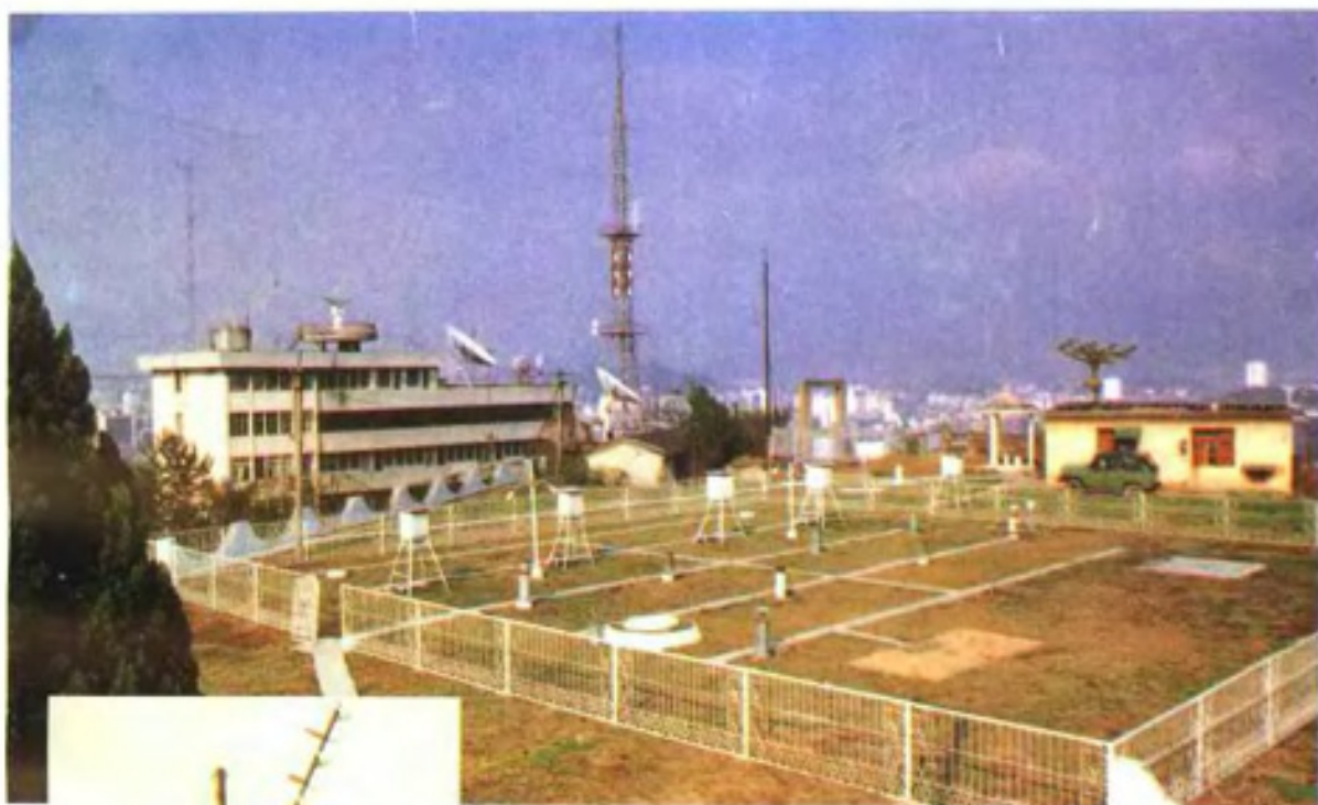
△福州国家基准气候站探测场地
