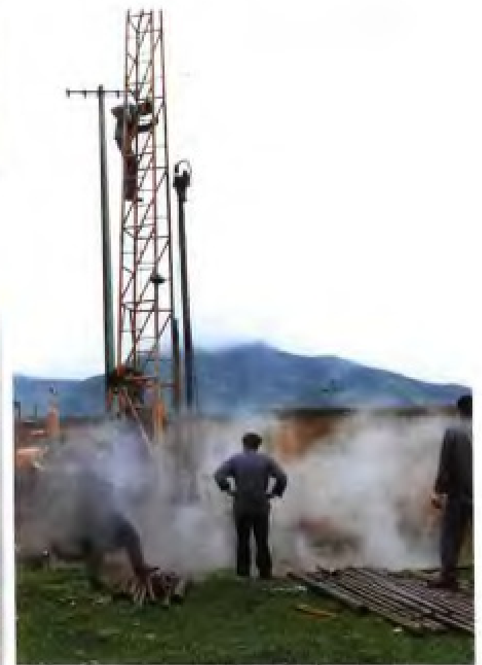
水压致裂试验
