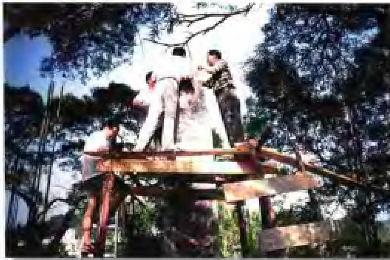
安装GPS观测点中心装置
