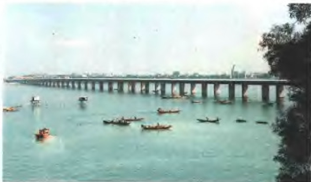
福建兴业银行贷款支持建设现代化跨海大桥——厦门大桥
