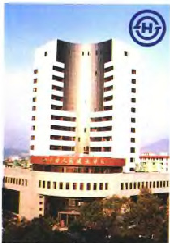
中国人民建设银行福建省分行办公大楼 地址：福州市古屏路
