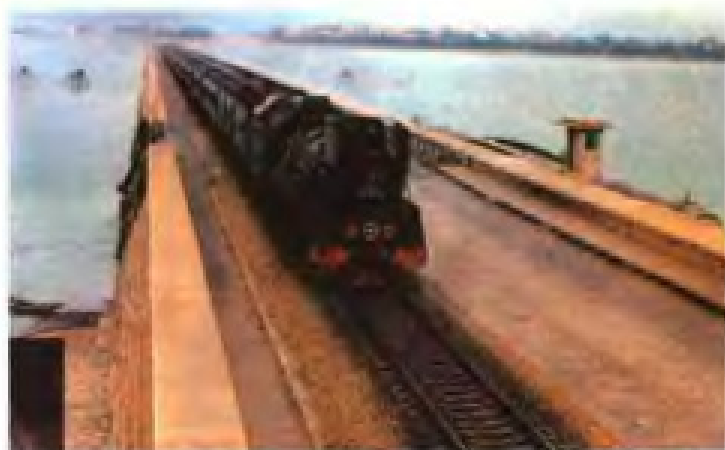
▲ 厦厦铁路高(崎)集(美)海堤
