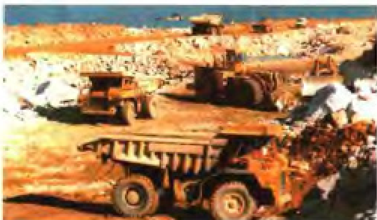
▶20世纪八九十年代土石方施工
