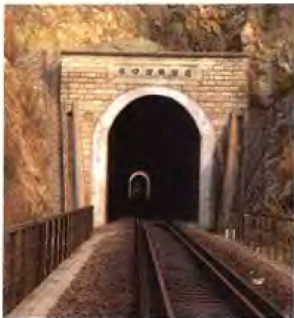
▲外福铁路水口隧道群之一
