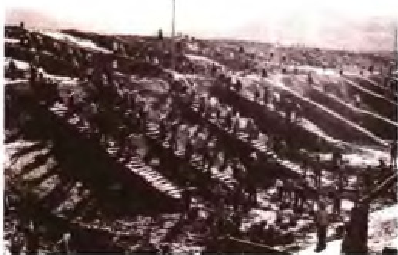
◀20世纪五六十年代土方施工
