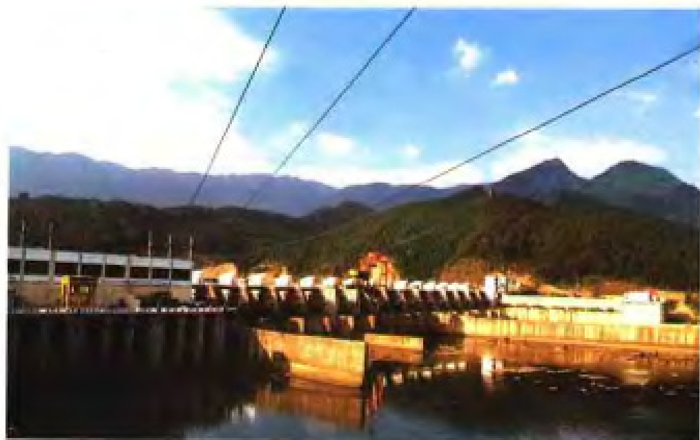
▶ 沙溪口水电站
