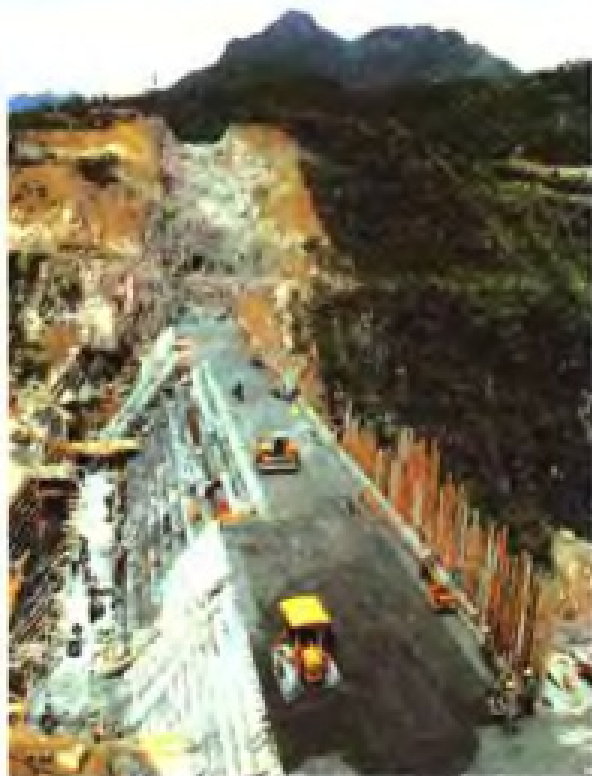
◀大田坑口水电站碾压混凝土重力坝施工(国内第一座采用碾压混凝土筑坝技术的水库大坝。1988年获国家科技进步一等奖)
