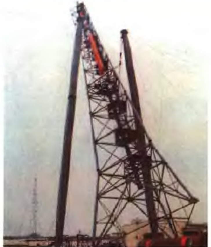
▲三联板多吊点滑移法吊装硫磺回收烟囱
