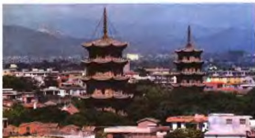
▲ 泉州东塔（镇国塔）西塔（仁寿塔）
