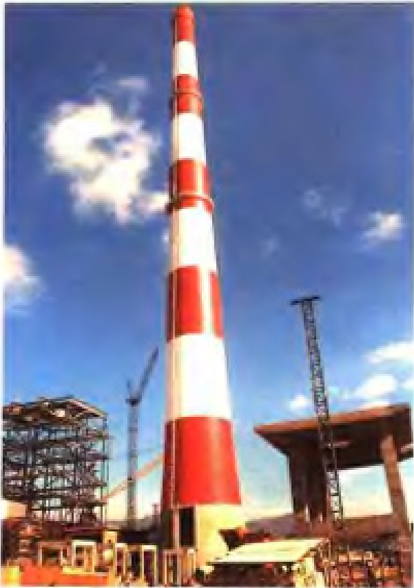
▲滑模施工的华能福州电厂210米烟囱 (1986年获省优质工程奖)
