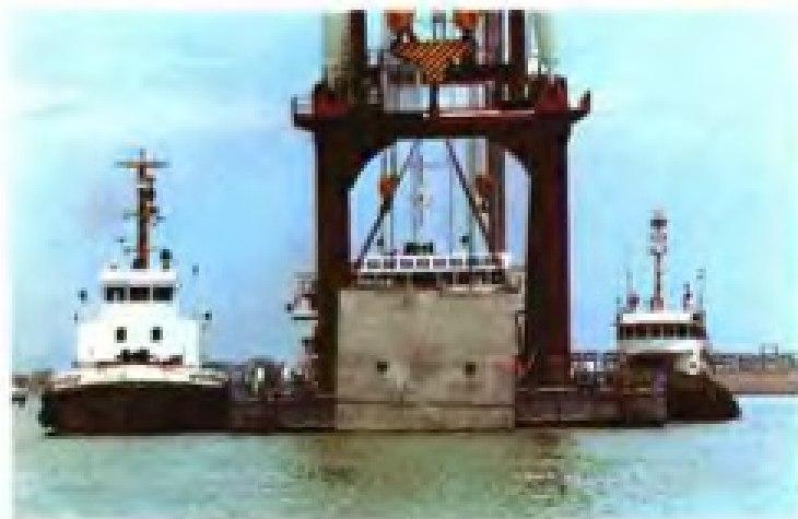
◀ 500吨沉箱出运安装工艺
