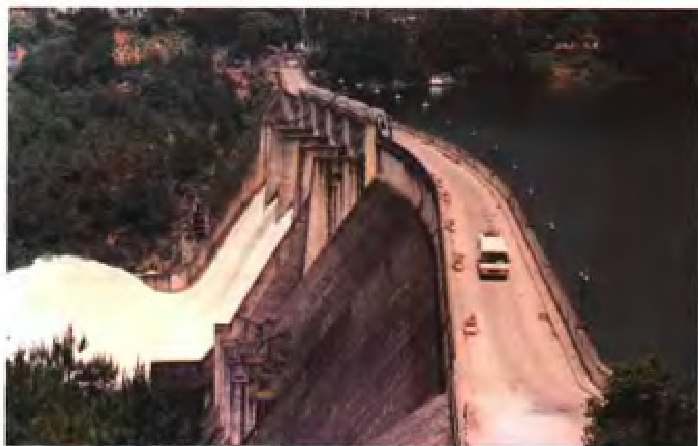
◀ 古田溪水电站一级水库 混凝土大坝
