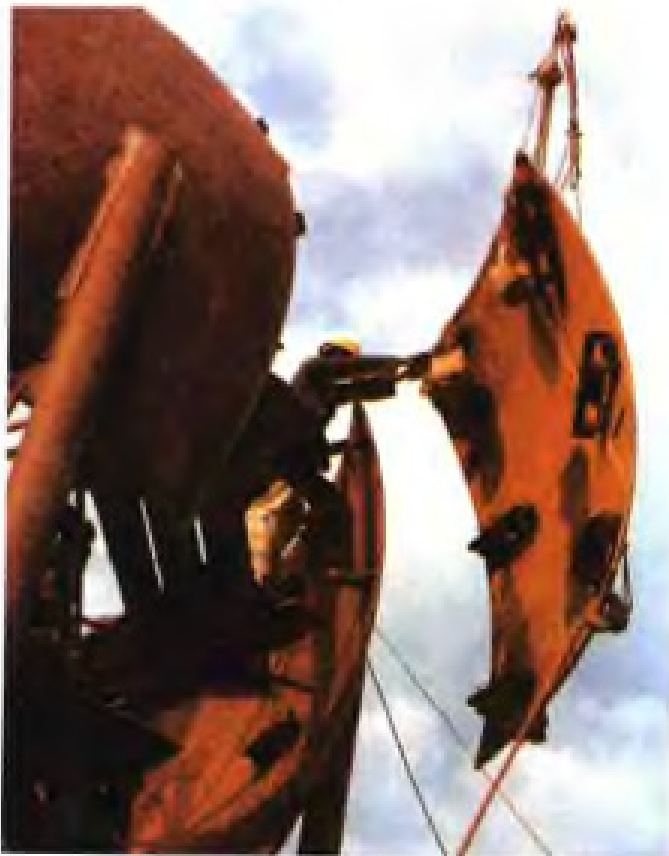
▲散装法组装球罐
