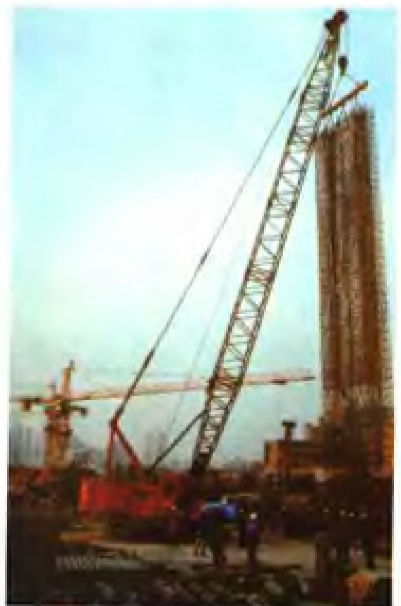
▲一次性起吊地下连续墙钢筋笼 (笼长24米, 宽6米, 重11吨)
