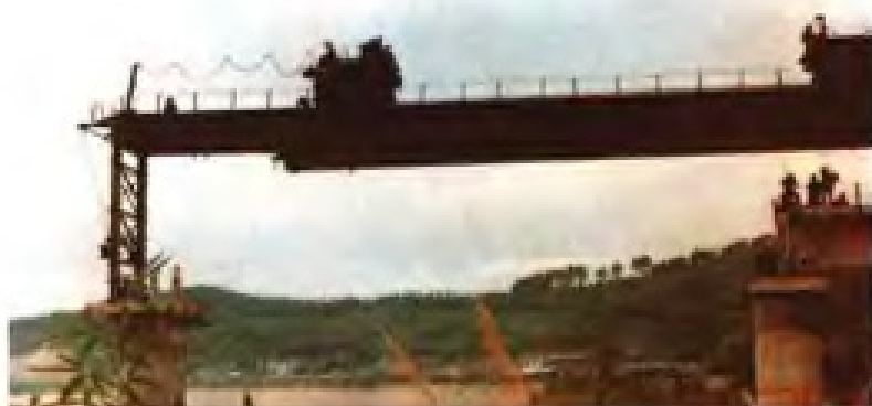
▲ 铁路桥架梁作业
