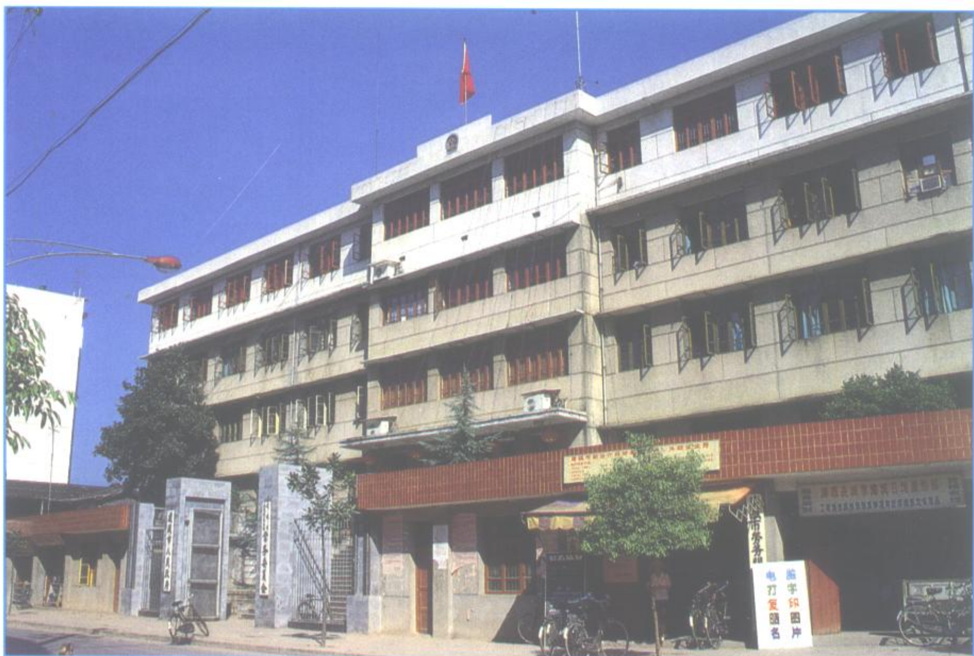
县政府办公大楼
