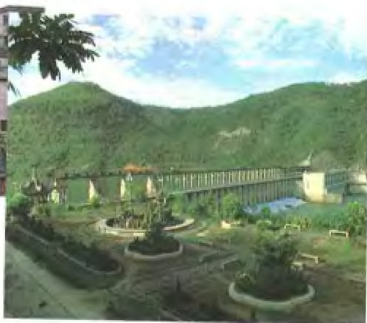
永安市鸭姆潭水电站
