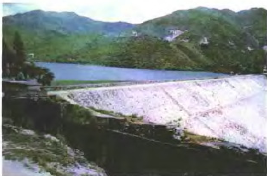
宁德金涵水库
