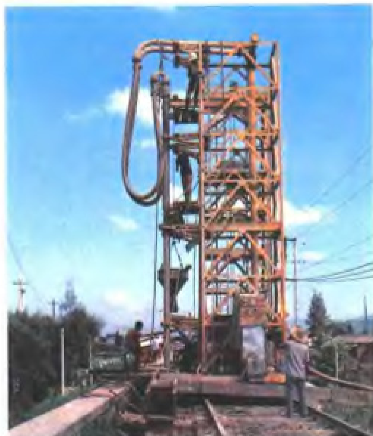
射水法建造混凝土地下连续墙(省水利科研所研究成果之一)
