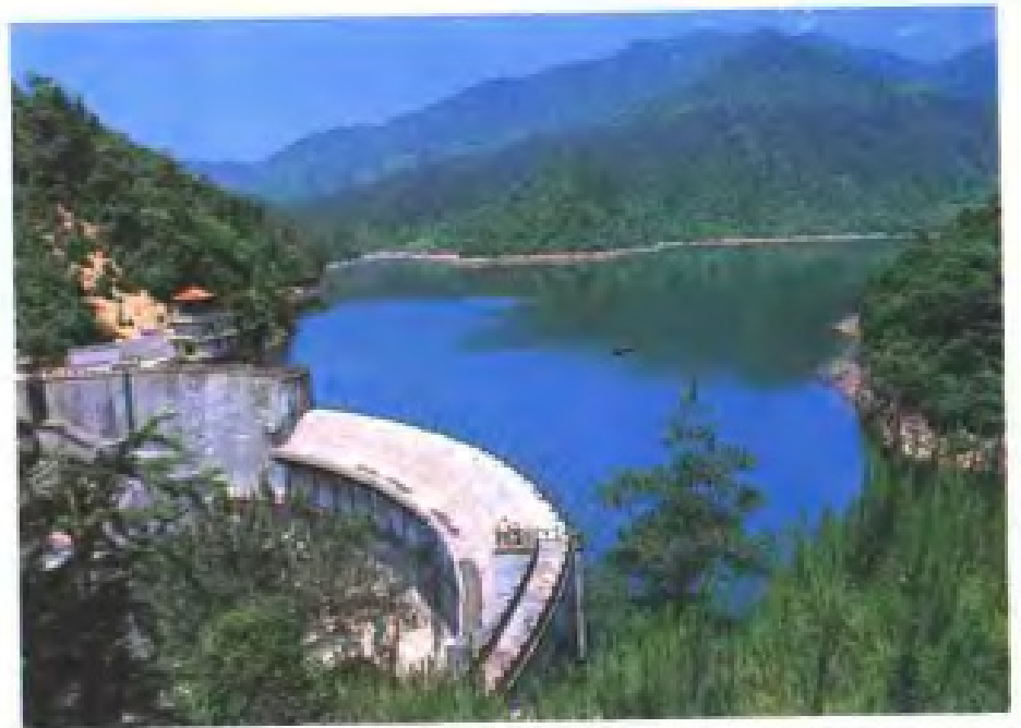
八闽农村电气化第一县—光泽县的高家水库
