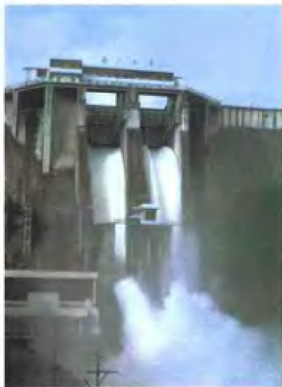
南一水库窄缝消能滞流状况
