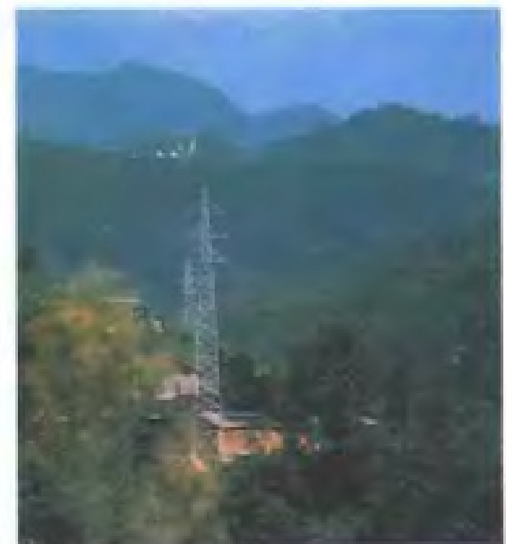
尤溪县城关至芦坪 35 千伏高压线路
