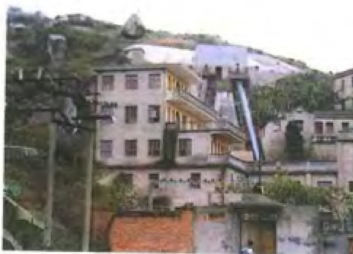
利用跌水发电的长乐三溪水电站
