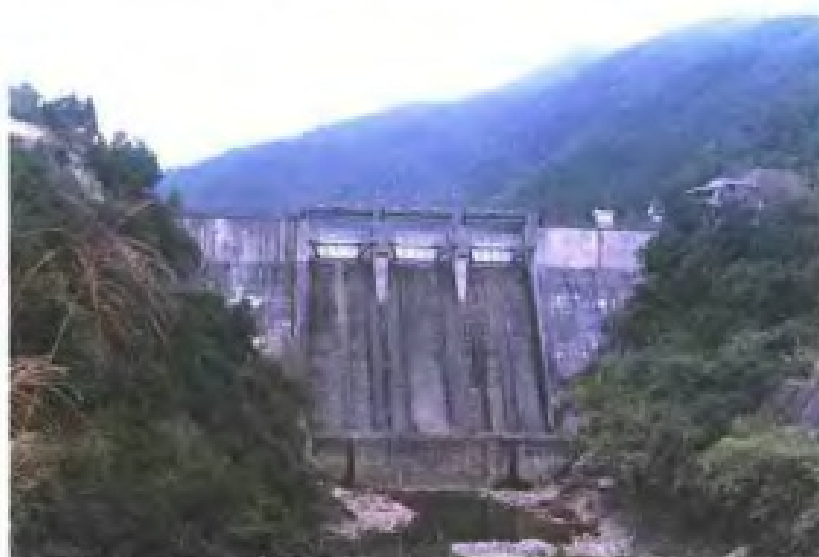
松溪茶州水库砌石空腹重力坝
