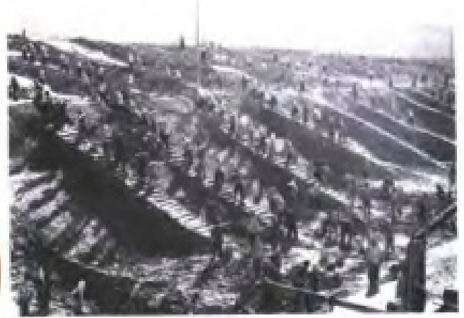
60年代, 山美水库工地场面
