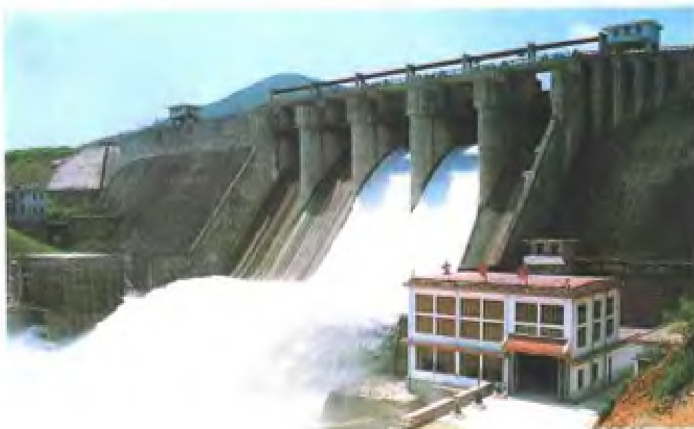
峰头水库砼砌石坝(坝前 为左右岸电站)
