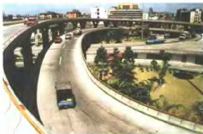
福州五里亭立交桥
