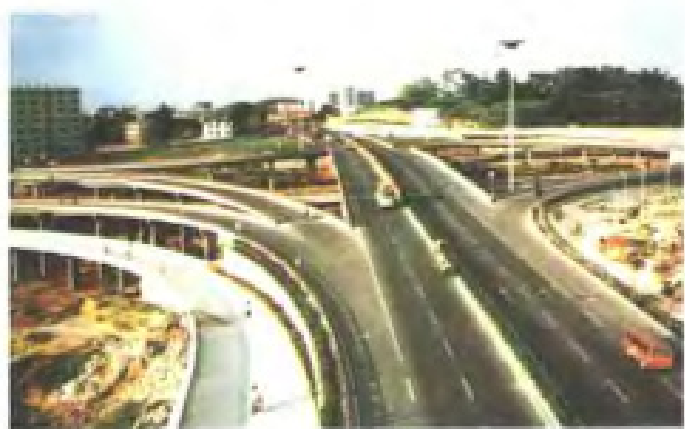
厦门厦鼓立交桥
