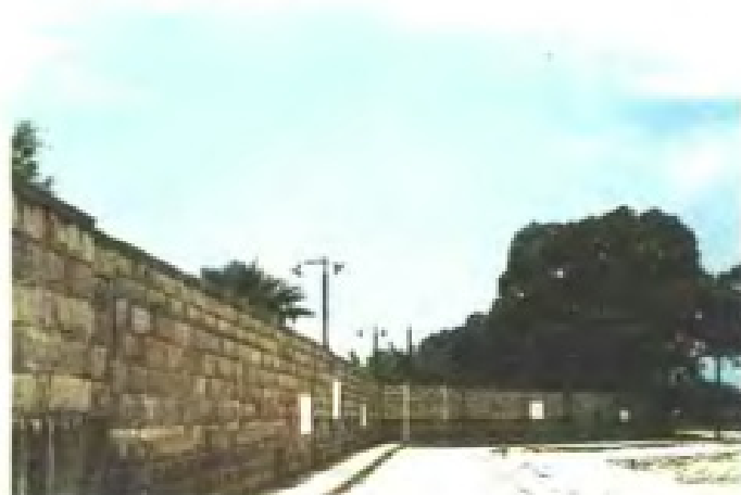
福州市区防洪堤
