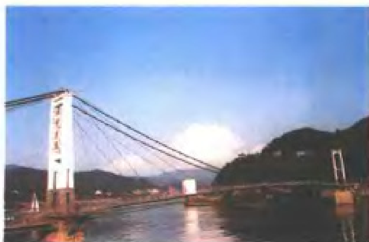
南平九峰山悬索桥
