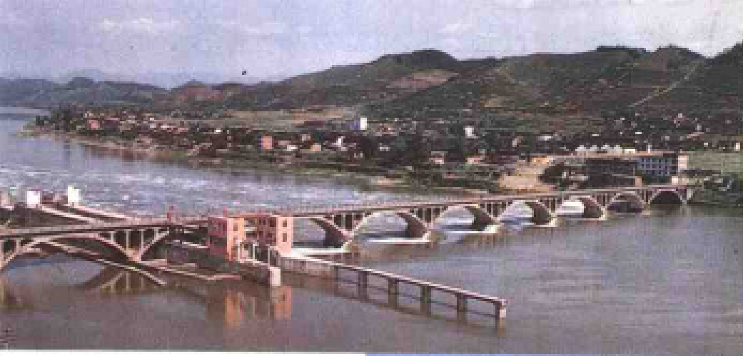
闽江复航第一闸——顺昌洋口船闸
