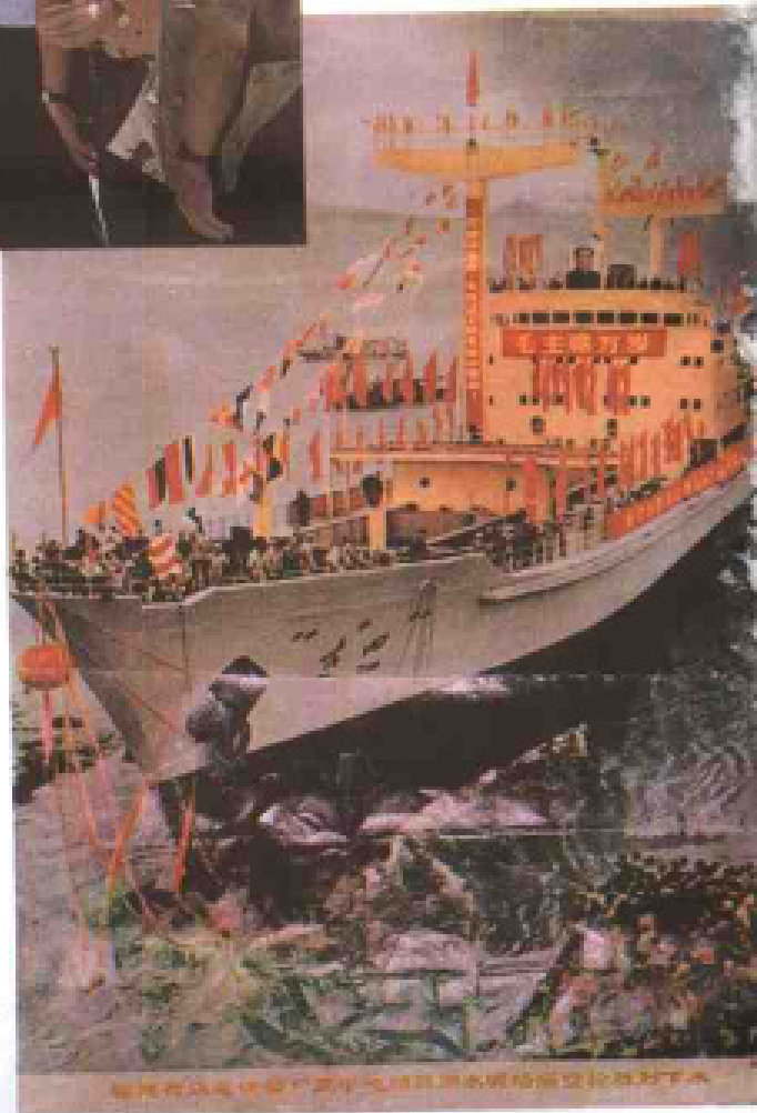
马尾造船厂建造的 3000吨级水泥质货 船“古田”号下水
