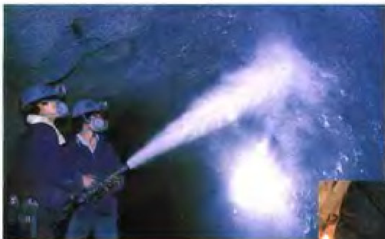
△锚喷支护工艺
