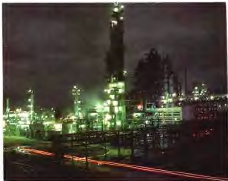
福建炼油厂厂区夜景
