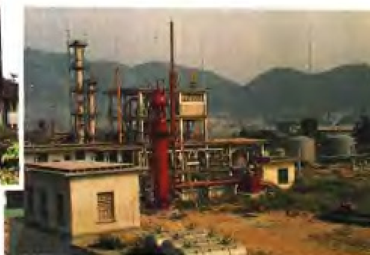
三明化工总厂甲醛生产装置
