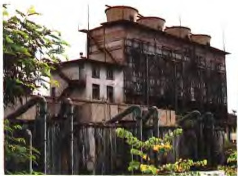
三明化工总厂污水处理装置
