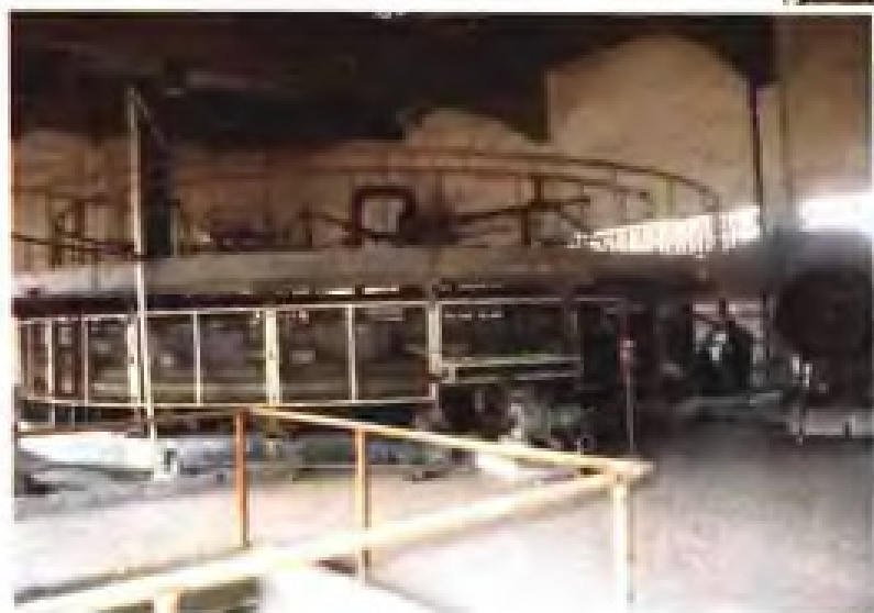
龙海磷肥厂3万吨/年磷酸车间圆盘过滤器
