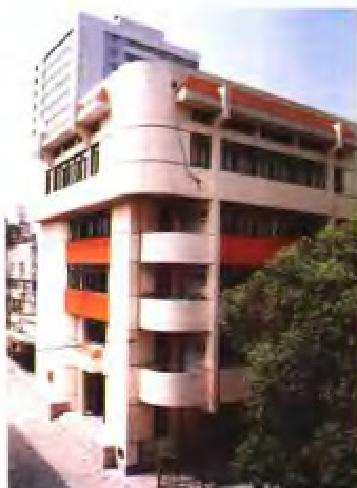
福建省石油化工厅办公楼
