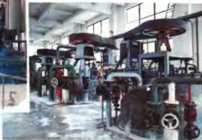
福安农药厂三唑磷车间一角
