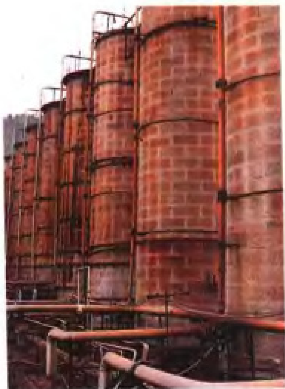
邵武化肥厂硝酸车间一角
