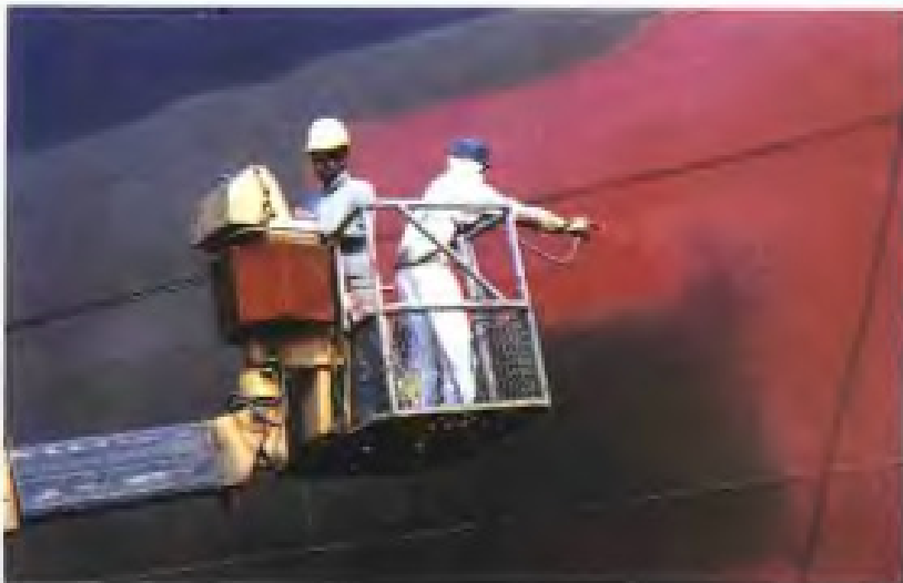
高压无气喷涂
