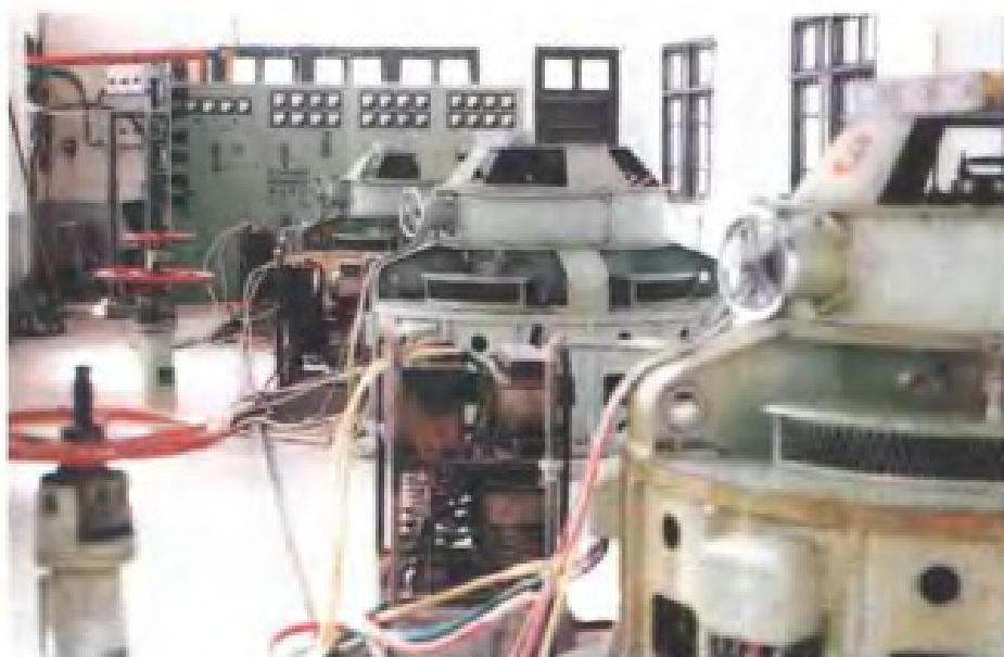
白花洋水电站
