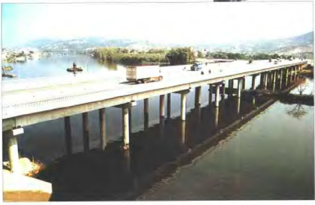
漳江鲤鱼洲大桥
