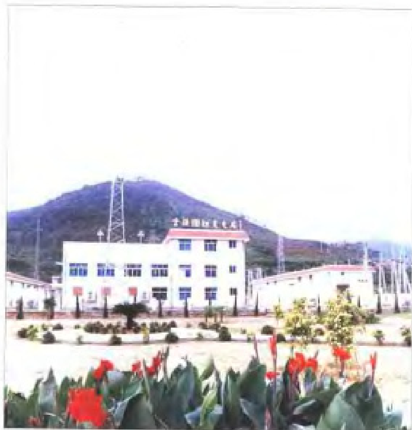
云陵11万伏变电站
