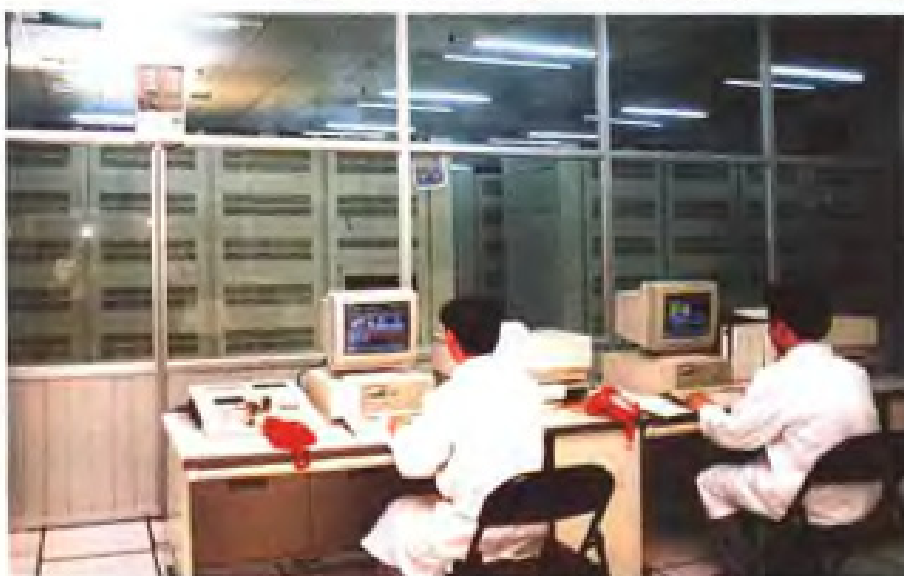
福州电信局引进日本富士通F-150型5万门程控电话交换机机房
