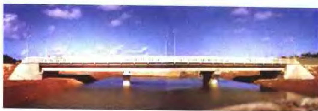
中福援外工程——安提瓜和巴布达围公路大桥
