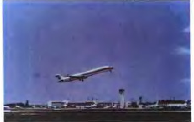
厦门国际机场
