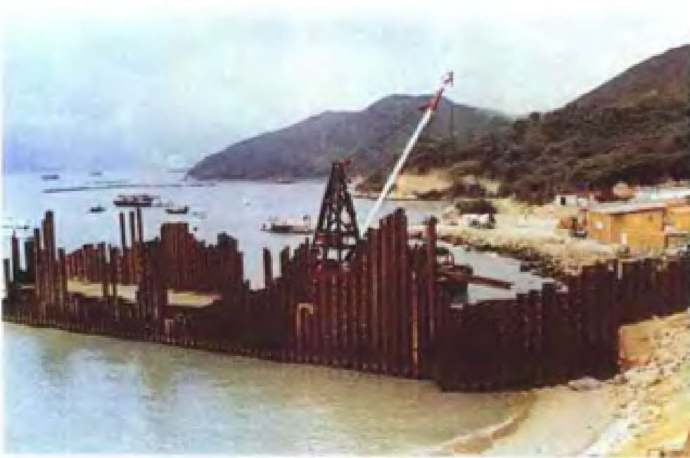
中福公司在香港承建的新机场十大工程之一的高速公路进行填海作业
