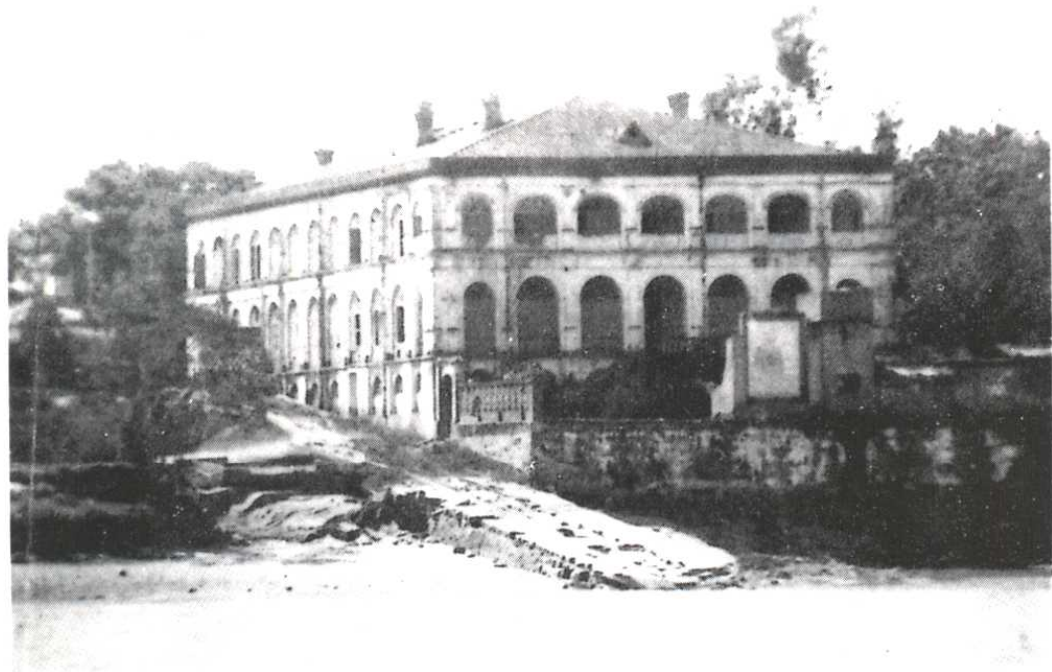
闽海关营前办事处办公楼旧址
